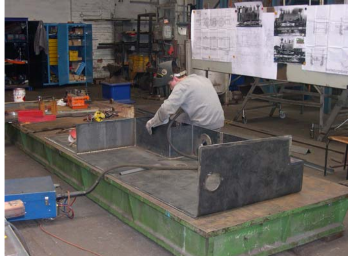
Schweißarbeiten am rechten seitlichen Wasserkasten begonnen.
